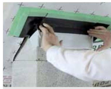
Mit der **Schachtabdichtung Innen** erstellen Sie eine **Abdichtung** von Schornsteinen oder anderen aufgehenden eckigen Bauteilen zur **Dampfdiffusionssperre**.
