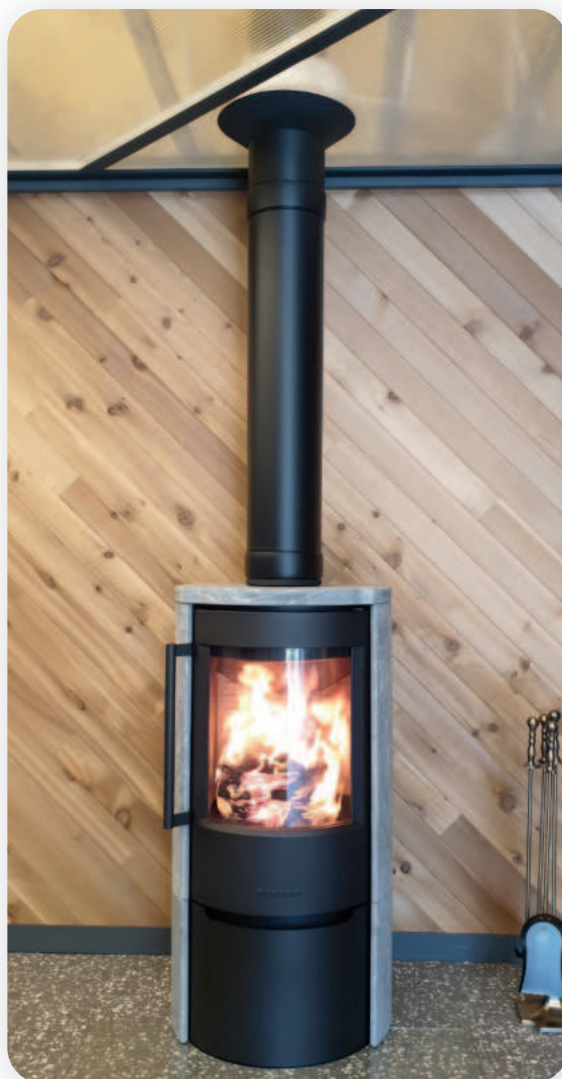
Aufgesetzter Schornstein auf Holzofen mit Deckendurchführung
