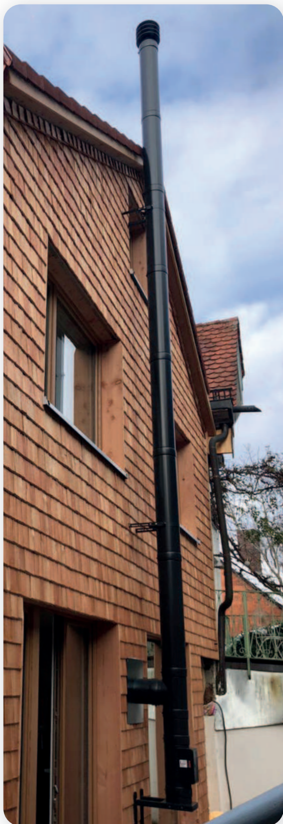
Aufbau an einer Holzfassade mit Wantmontage
