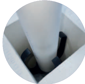
Detailbild PolyStar in Porenbetonschacht mit Abstandshalter
