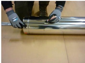
Markieren Sie die Länge am Rohr um die Sie das Rohrelement kürzen wollen. Beachten Sie das das Rohr immer auf der Sickersseite gekürzt wird.
