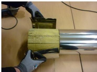
Nun können Sie das Rohr aufbiegen und entfernen. Schneiden Sie dann mit einem Messer die offen gelegte Dämmung sauber an der Schnittkante des Außenrohres ab und legen Sie somit das Innenrohr frei.
