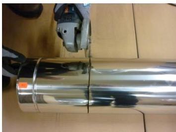
Schneiden Sie dann das Außenrohr mit dem Winkelschleifer entsprechend der Markierung. Bitte nutzen Sie unbedingt eine saubere Trennscheibe für Edelstahl, mit der Sie vorher kein anderes Eisen geschnitten haben. **Ein Tipp:** Einen geraden Schnitt bekommt man am besten hin, wenn das Rohr auf dem Boden liegend während des Schneidens gedreht wird.
